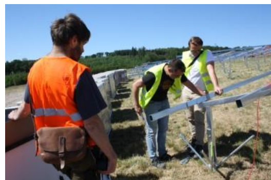
Baubesprechung mit Herrn Depenbrock (Architekt) und Herrn Niemeier (Planet in Green)
